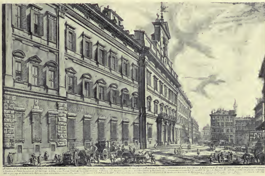
THE PALAZZO DI MONTE CITORIO. 23, I
